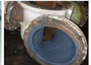
容器承压件修补
